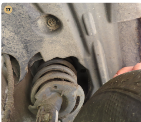
✓ Futómű A lengéscsillapítón olajfolyás nem észlelhető.
