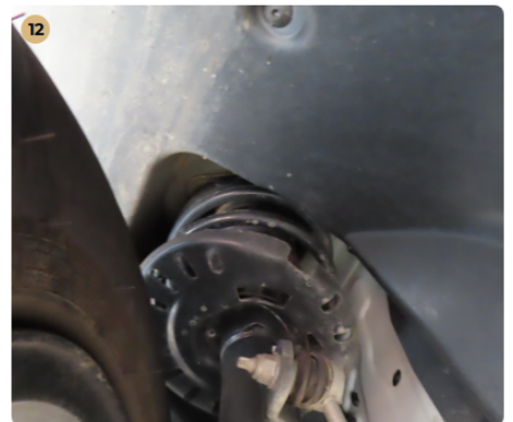
✓ Futómű A lengéscsillapítón olajfolyás nem észlelhető.
