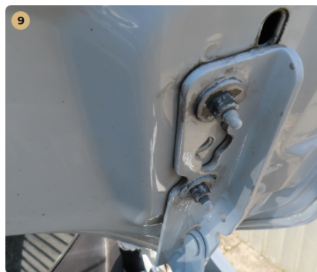
⚠ Külső karosszéria elemek Motorháztető volt leszerelve.
