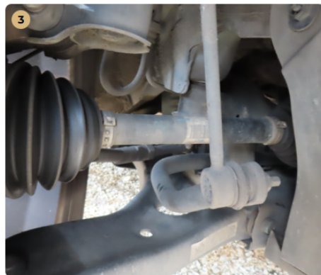
✓ Futómű A gumiharangokon szakadás, repedés nem látható.
