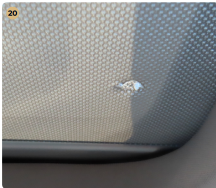
20 Kárpitozás és belső burkolatok Panoráma tetőn lyuk látható.
