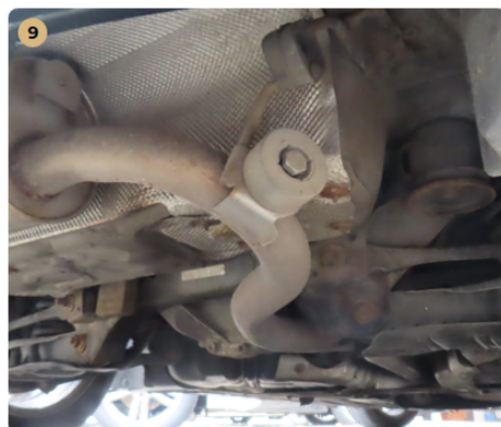
! Utascella és gyűrődő zónák Alvázon minimális felületi korrózió látható
