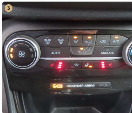
✓ Elektromos berendezések Gombvilágítások megfelelően működnek.
