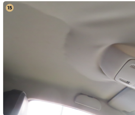
! Kárpitozás és belső burkolatok Tetőkárpit javítást, felújítást igényel.
